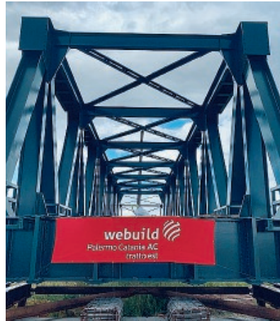
Il viadotto posato sul torrente Buttaceto
