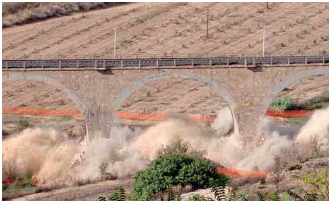
LE CARICHE DI ESPLOSIVE CHE IL 9 OTTOBRE SCORSO HANNO ABBATTUTO IL PONTE PARZIALMENTE CROLLATO L'8 MAGGIO 2011
