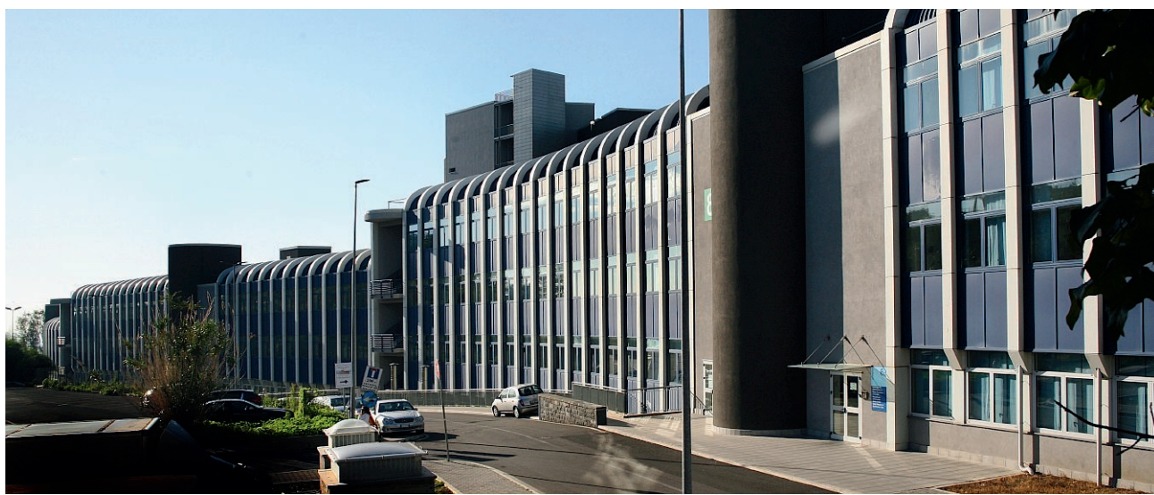
Nelle foto: sopra, una delle sale operatorie del "Serpentone"; accanto, veduta esterna del Padiglione 8 del Policlinico dalla caratteristica forma di serpente
