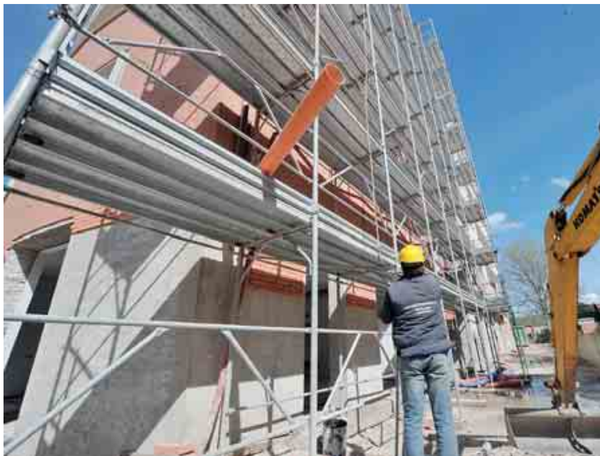
UNA CASA IN COSTRUZIONE, LA SICUREZZA NEI CANTIERI UN ALTRO ASPETTO DA SALVAGUARDARE
