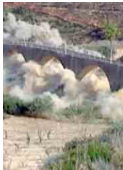
LA DEMOLIZIONE RISALE AL 12 NOVEMBRE SCORSO
