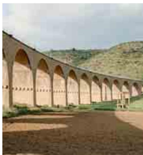
IL PONTE DI NISCEMI PRIMA DEL CROLLO
