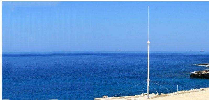
so» e «Calypso Follow On» (Programma Italia-Malta 2007-2013) che hanno permesso di attivare già dall'ottobre 2013 un Sistema Hf permanente ed operativo costituito da tre antenne (una installata nell'area portuale di Pozzallo ed altre due a Malta nei siti di Ta' Barkat e Ta' Soppu) poi potenziato nel 2015 con l'installazione di una quarta antenna nel porto turistico di Mari-
